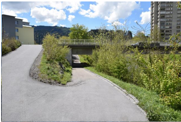
1) km. 39.9 Waisenhausbrücke rechts: Blickrichtung Ebnat-Kappel
