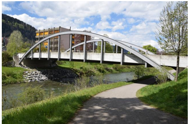
4) km. 38.4 Rietwiesbrücke: Blickrichtung Lichtensteig
