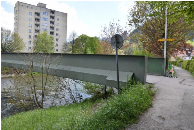
15) km. 37.0 Schomattensteg links: Blickrichtung Ebnet-Kappel
