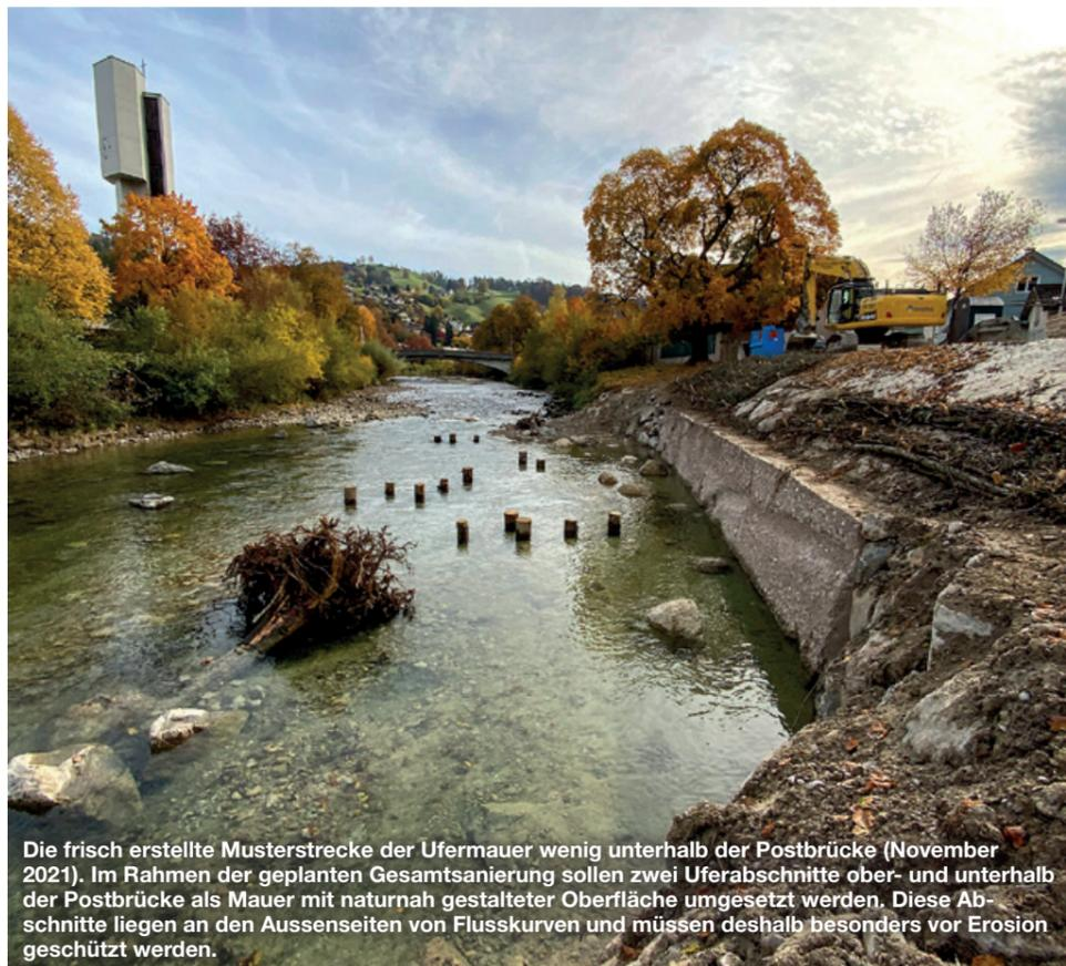
Die frisch erstellte Musterstrecke der Ufermauer wenig unterhalb der Postbrücke (November 2021). Im Rahmen der geplanten Gesamtsanierung sollen zwei Uferabschnitte ober- und unterhalb der Postbrücke als Mauer mit naturnah gestalteter Oberfläche umgesetzt werden. Diese Abschnitte liegen an den Aussenseiten von Flusskurven und müssen deshalb besonders vor Erosion geschützt werden.
