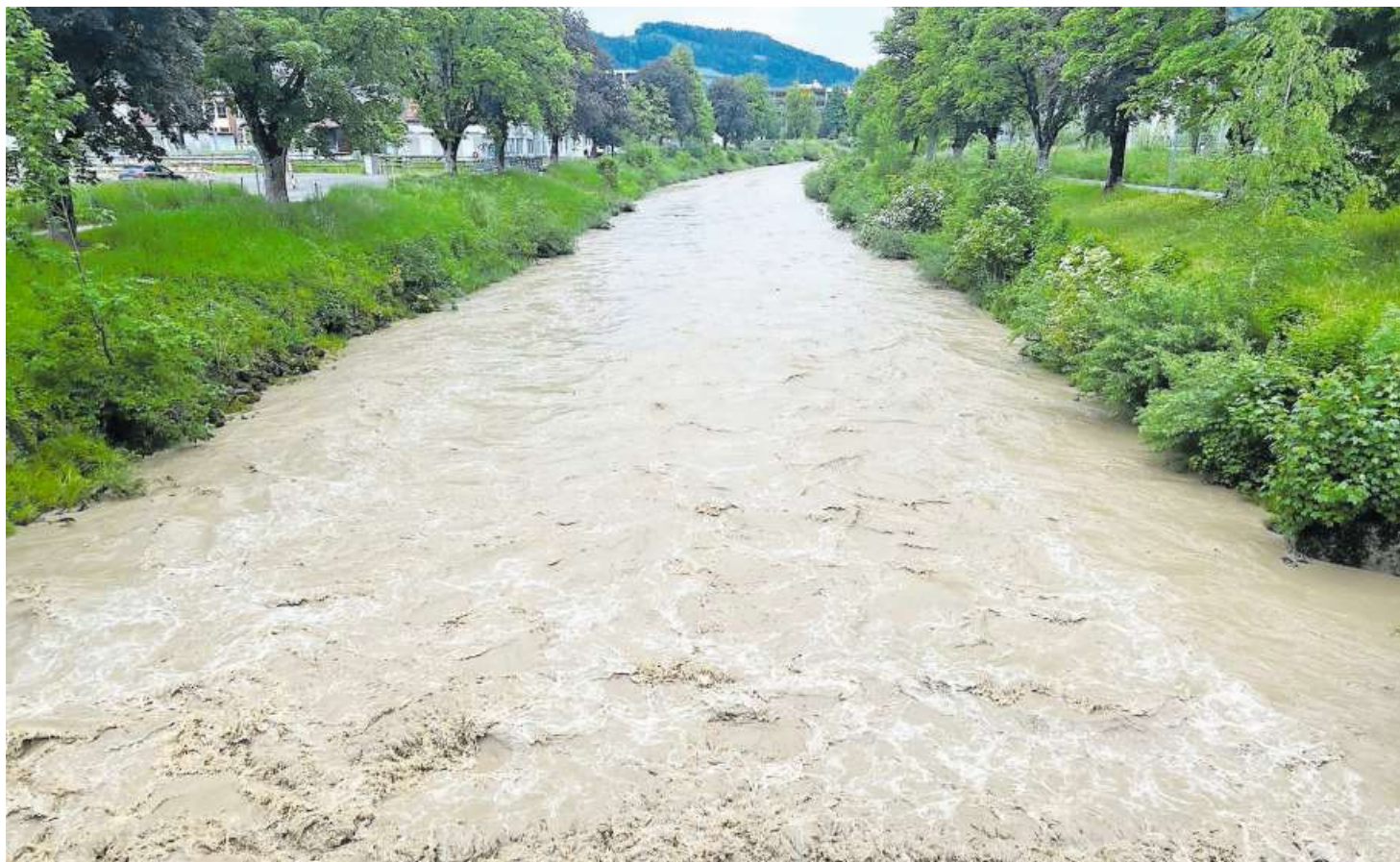
Während der Unwetter der vergangenen Wochen führte die Thur in Wattwil viel Wasser. Die geplante Thursanierung soll vor einem 300-jährigen Hochwasser schützen. Bild: Simon Dudle
